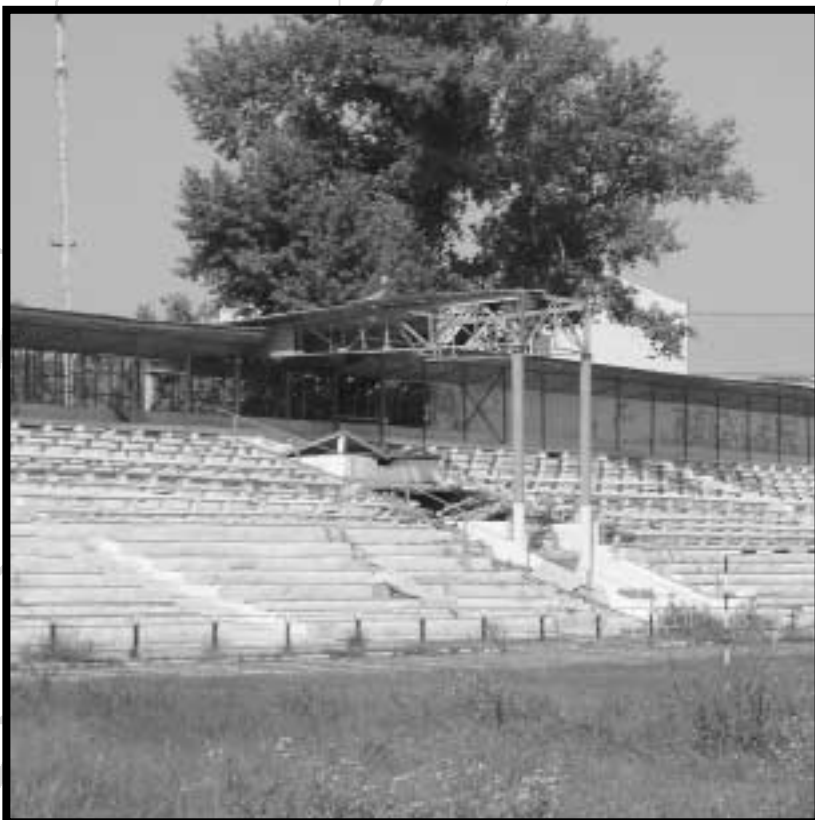
Stadion – Ort des Anschlags auf Kadyrow im Mai 2004
